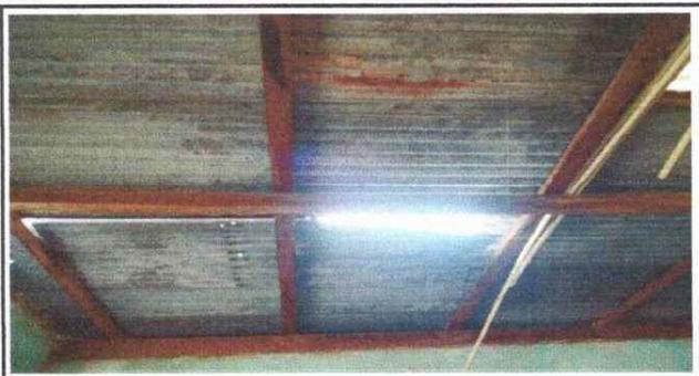
Foto1: Sustitución de lámina, por lámina troquelada aluzink calibre 26 original
